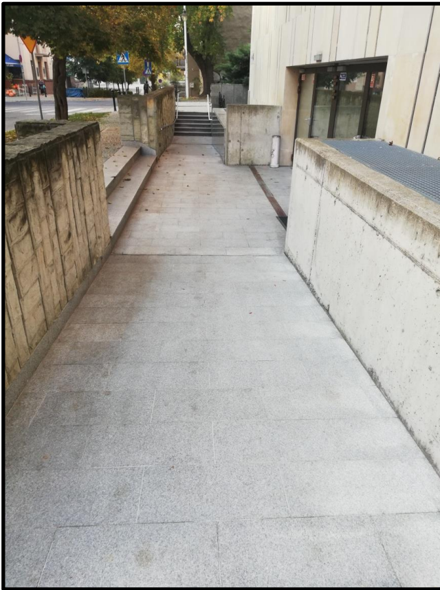
Podjazd na końcu ulicy Artura Grottgera.
